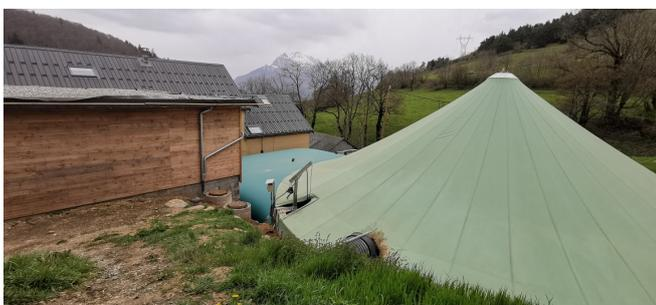
L'espace de méthanisation, sous l'étable : le lisier récupéré permet de chauffer les bâtiments
